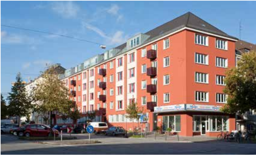
Die Gebäude Holtenauer Straße 218-224 in Kiel vor (r.) und nach (l.) der Sanierung und Modernisierung 2008
