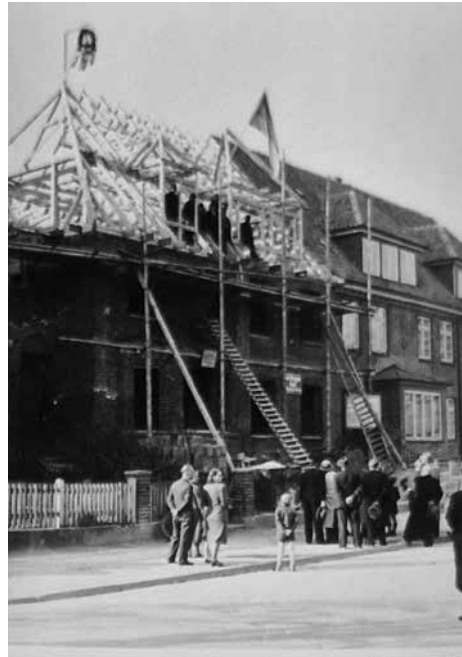
Richtfest für den Neubau im Forstweg 29a in Kiel für drei große Wohnungen (80-100 m 2 ), 1951
