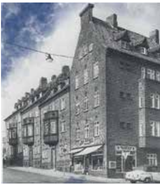
Wohnhausgruppen in Kiel (oben: Schleusenstraße 13-33, unten: Ziegelteich 16-20) die bis 1926 nach Entwürfen Hahns entstanden
