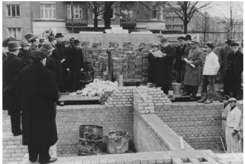
Besichtigung der Baustelle Hasseldieksdammer Weg/Gellerstraße mit Vertretern der Stadt Kiel, 1949
