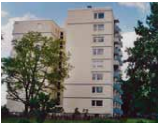
Das erste „Hochhaus“ des Postbauvereins im Moorkamp 1 in Kiel
