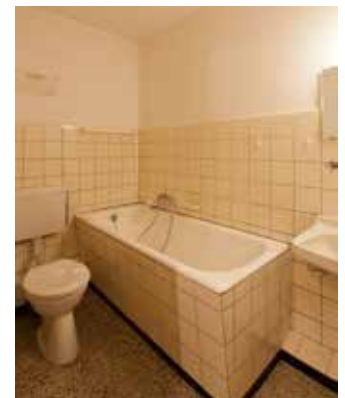
Strangsanierung der Bäder in der Von-Stephan-Straße 2 in Kronshagen 2014
