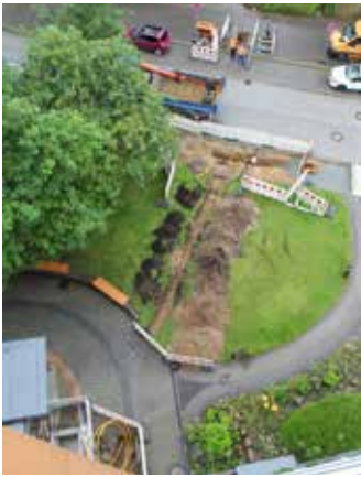
Erneuerung der Gasleitung im Postillionweg, Kiel, im Sommer 2020
