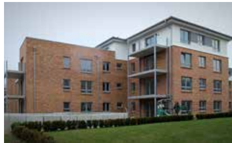
Das neu erbaute Quartier „Mühlenhof“ in Bordesholm nach der Fertigstellung 2018
