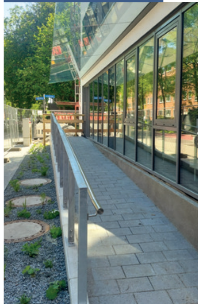
BARRIEREFREIE RAMPE EINGANGSBEREICH
