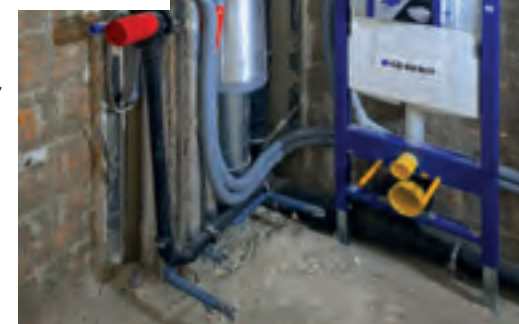
Badezimmer: vor der Strangsanierung, während der Strangsanierung, nach der Strangsanierung
